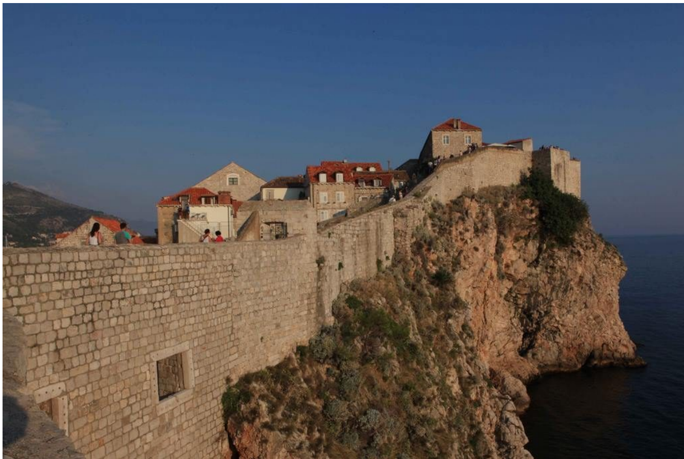
Vue sur une partie des remparts.
