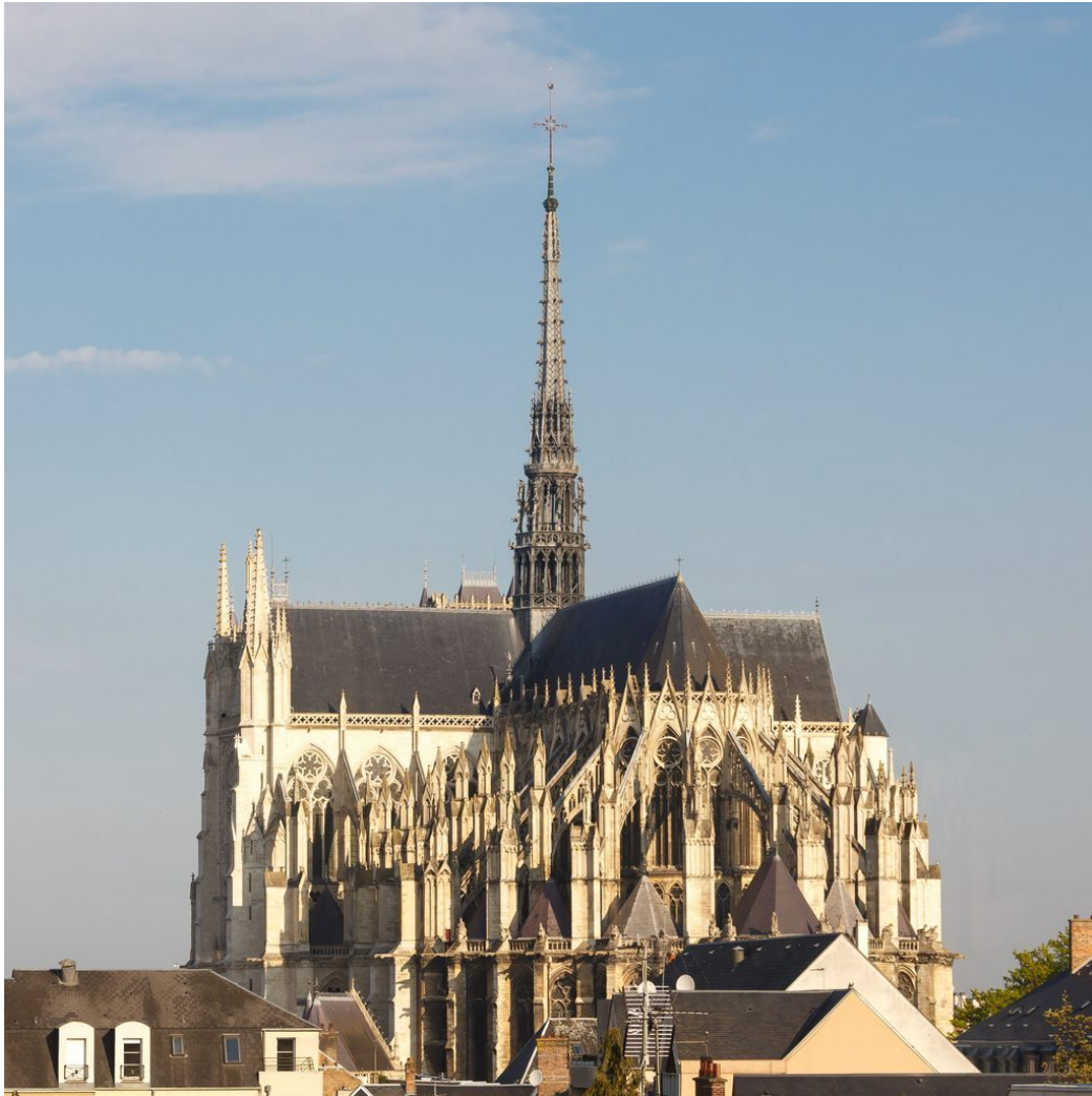
France. Cathédrale Notre-Dame d'Amiens. Les arcs-boutants contrebutent la poussée des voûtes et assurent la stabilité de l'édifice. © CEphoto, Uwe Aranas/ Commons.
