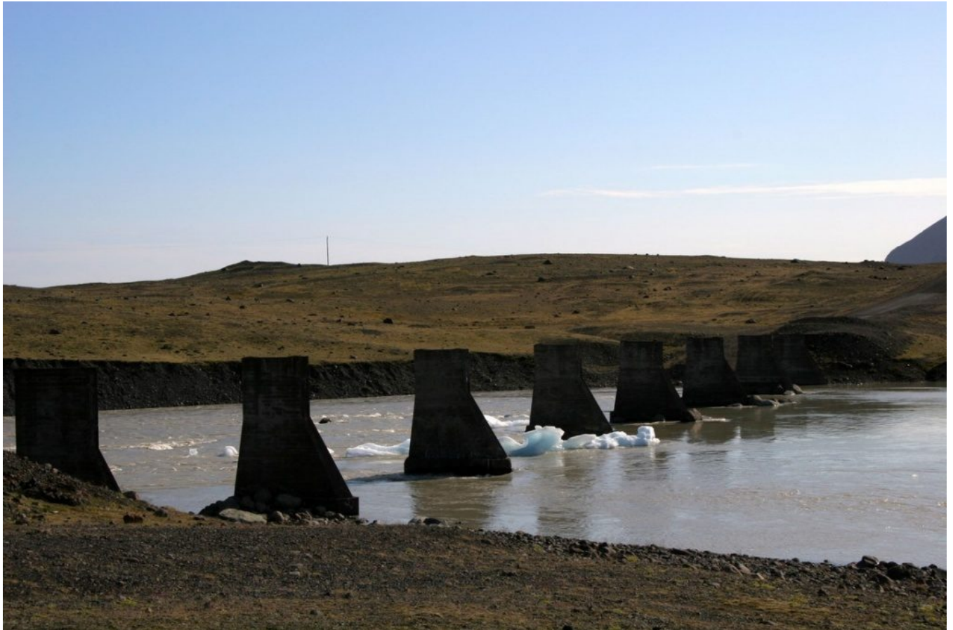
Vestige d'un pont de la route N° 1 détruit par le jökulhlaup suite à l'éruption du Grímsvötn en 1996.
