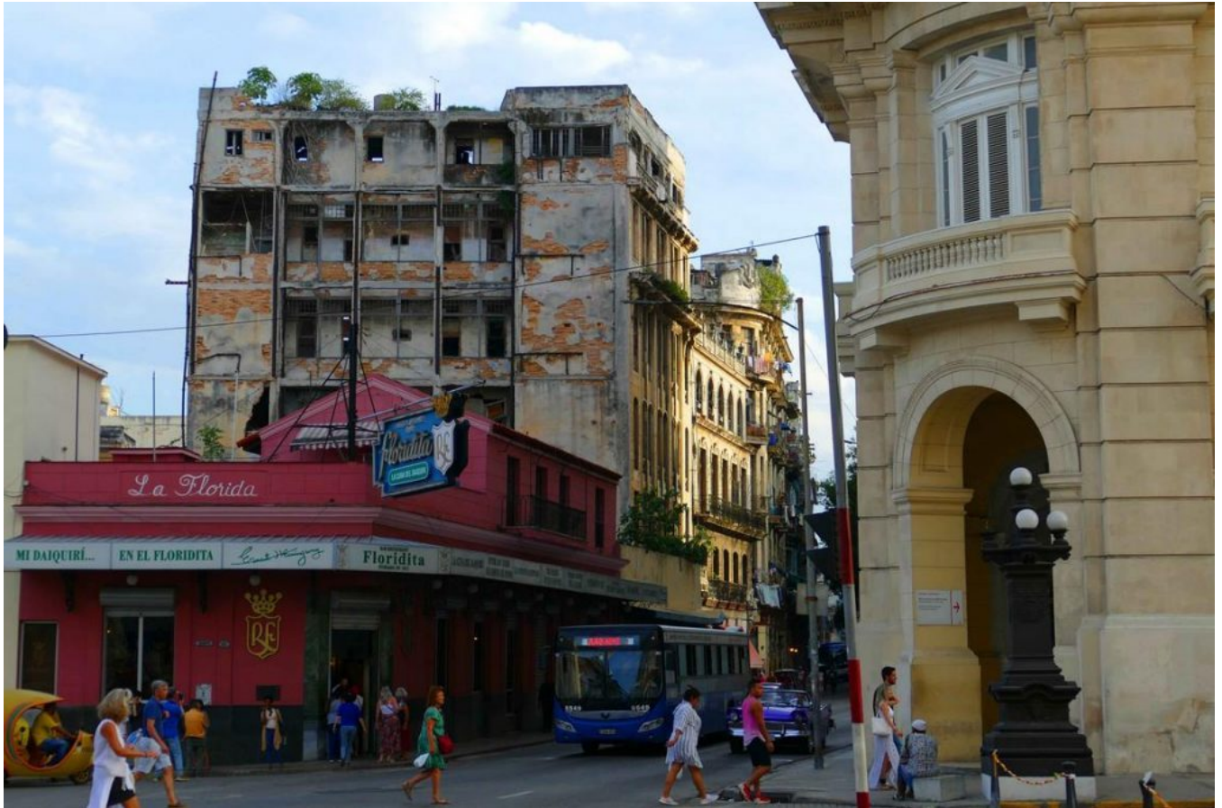
La Havane. Un des nombreux bâtiments en péril jouxte le célèbre bar La Florida où Hemingway venait boire ses daiquiri.
