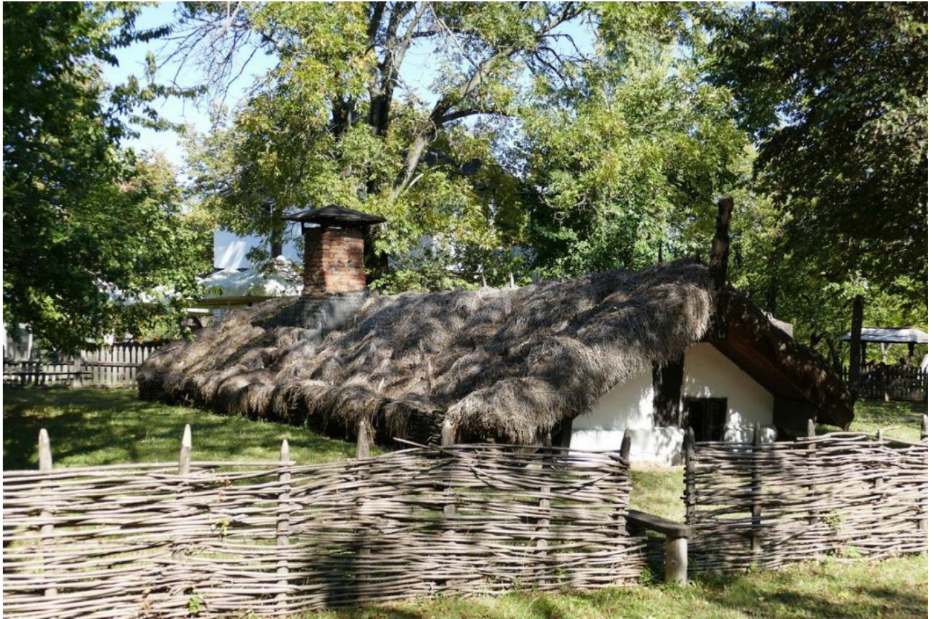
Roumanie. Bucarest. Maison traditionnelle semi-enterrée , avec son double toit en bois de chêne recouvert de canne, de paille et d'argile, provenant du village de Draghicieni, déplacée dans le musée Dimitrie Gusti.
