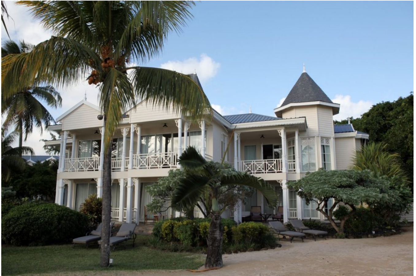
Heritage Le Telfair. Une des résidences de l'hôtel nichée dans la verdure.
