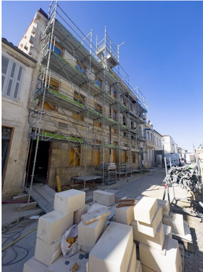
Maison de Pierre Loti en cours de rénovation. Ouverture prévue en 2025...
