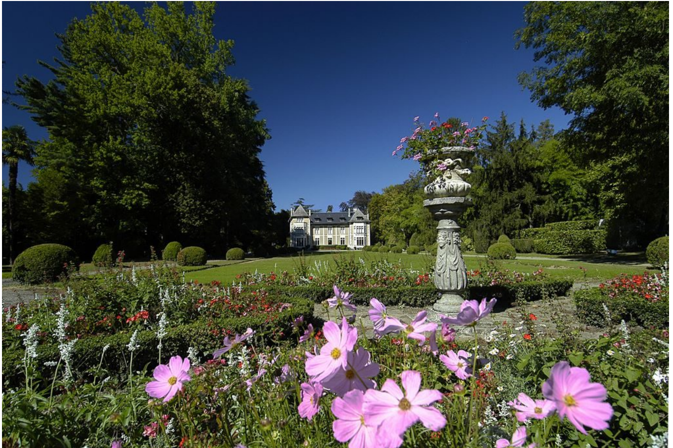
France. Pau. Construite en 1889 par un rentier parisien, la villa Saint Basil's, au 61 avenue Trespoey, fut la propriété de M. Tooley, époux d'une riche héritière argentine, avant de revenir à la ville de Pau. © OT Pau.
